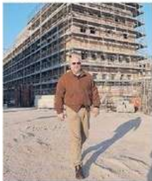
IL CANTIERE E segretario del Sap, Andrea Carobbi Corso, davanti alla nuova sede della questura, all'Via Brada
